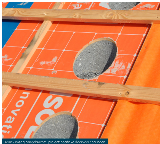
Fabrieksmatig aangebrachte, projectspecifieke doorvoer sparingen.
