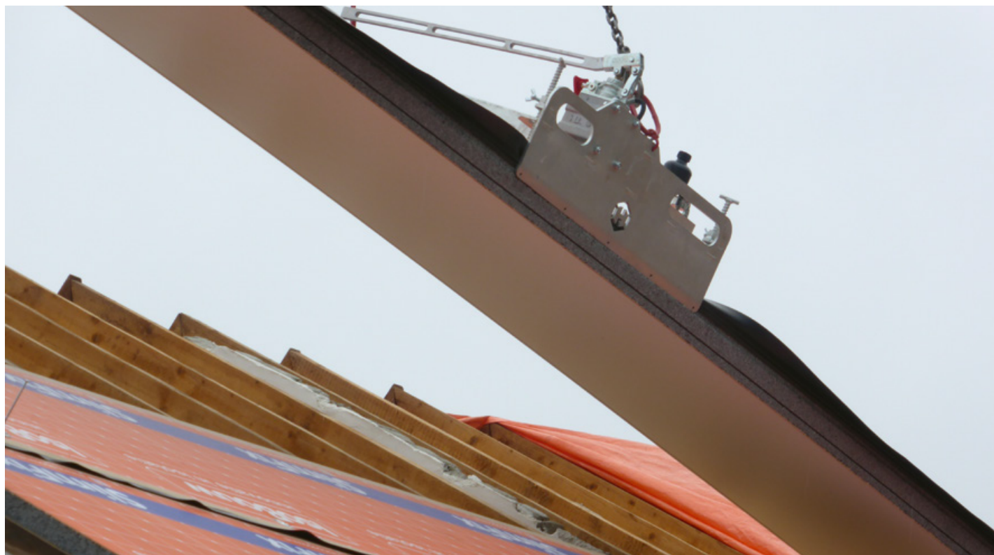
Te monteren met een HTZ dakplatenklem.
