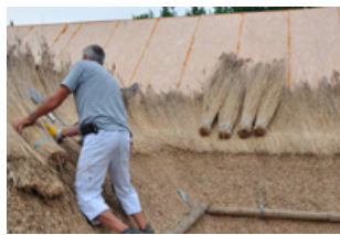
SlimFix XT Riet voor rietdaken (nieuwbouw/renovatie)
