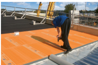
Plat dak isolatie
