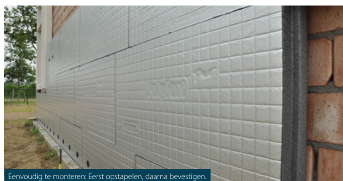
Eenvoudig te monteren: Eerst opstapelen, daarna bevestigen.
