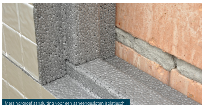
Messing/groef aansluiting voor een aaneengesloten isolatieschil.
