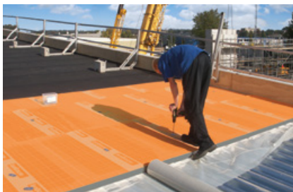
Plat dak isolatie
