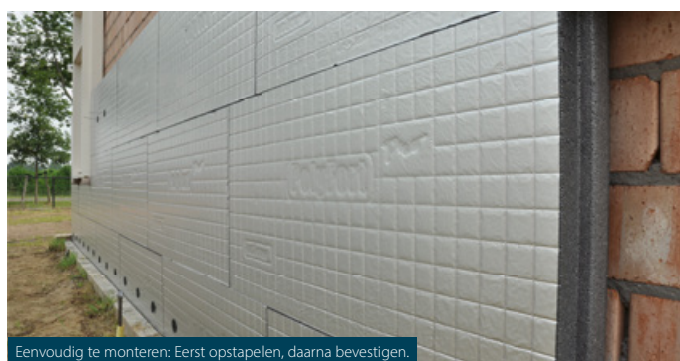
Eenvoudig te monteren: Eerst opstapelen, daarna bevestigen.
