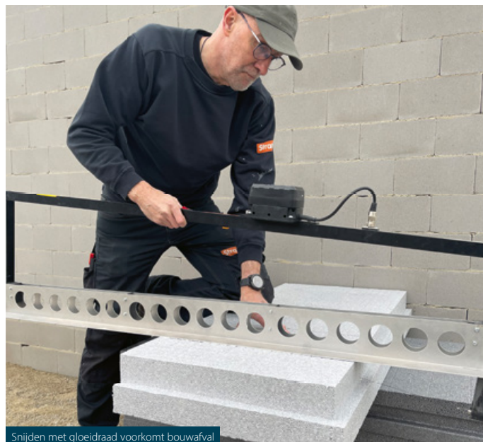
Snijden met gloeidraad voorkomt bouwafval
