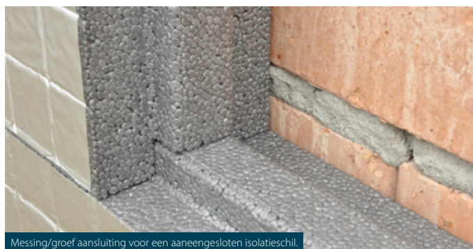
Messing/groef aansluiting voor een aaneengesloten isolatieschil.
