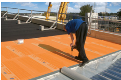
Plat dak isolatie
