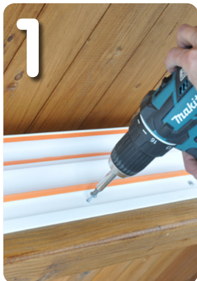
Randprofiel vastschroeven = luchtdichtheid
