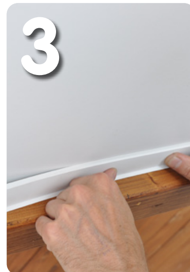
Klikprofiel bevestigen = esthetische afwerking
